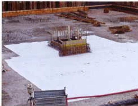
Meilen Objekt: Einfamilienhaus Justrain System: Drytech Swiss Weisse Wanne Plus Realisierung: 2012
