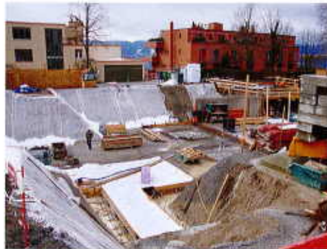
Zürich Objekt: Ersatzneubauten Steinbrüchelstrasse System: Drytech Swiss Weisse Wanne Plus Realisierung: 2012/2013
