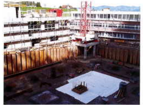
Feusisberg Objekt: Gewerbehause Ludwig System: Drytech Swiss Weisse Wanne Plus Realisierung: 2012/2013
