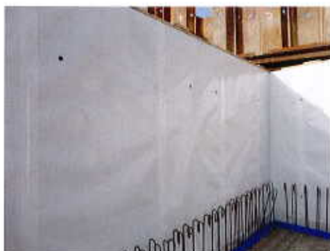
Gibswil Objekt: MFH Rosenbergstrasse System: Drytech Swiss Weisse Wanne Plus Realisierung: 2013
